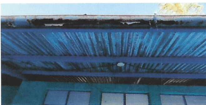
Foto 5: Canales deteriorados.
